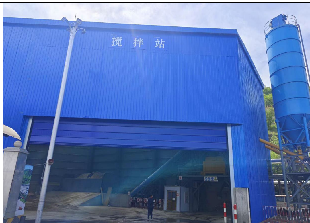
全封闭搅拌站
