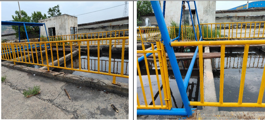
依托厂区原有的沉淀池
