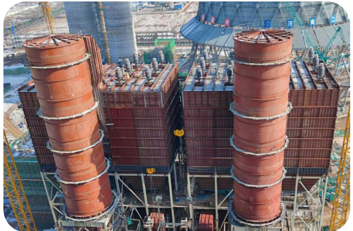
近日，彬长发电公司超超临界CFB示范机组项目再传捷报，一号机组脱硫吸收塔顺利结顶。
